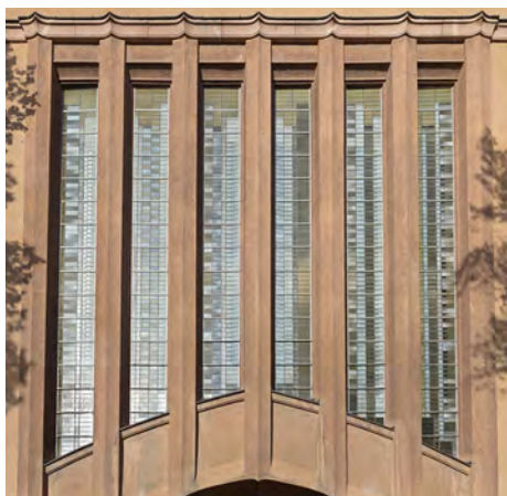
Blick vom Mittelhof auf das Fenster-Ensemble
